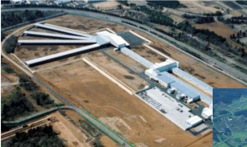
燃料電池自動車 安全性評価試験棟
