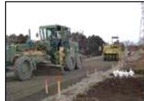
丁張りに合わせて施工
